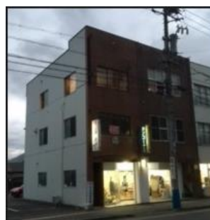
第二教室 訓練施設外観
